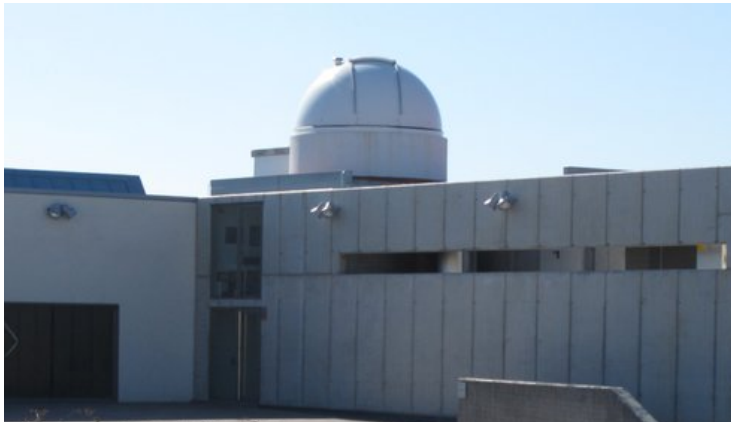
Figura VII: Cúpula semiesfèrica de l'observatori de Can Roig des de l'exterior
